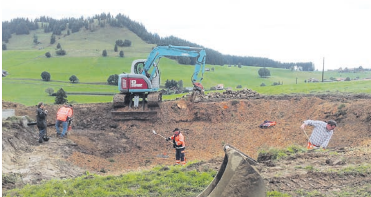
Zurst waren Aushubarbeiten nötig.
