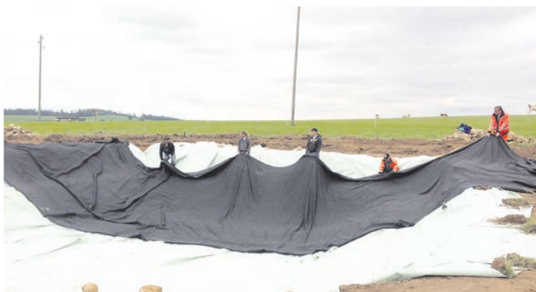
Dann wurde der Weihergrund mit einer speziellen Membrane abgedichtet.
